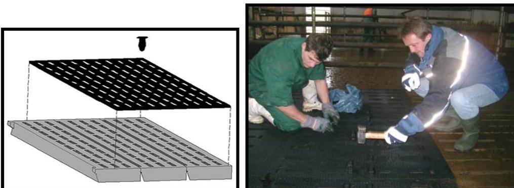
Abbildung 5: Gummimontage: Fixieren der Gummimatten mit Gummikeilen
