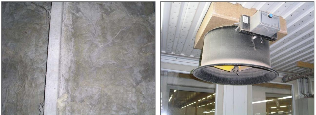
Abbildung 16: Mineralwolle zur Zuluftführung (li.) und Abluffeinheit mit Messventilator (re.)
