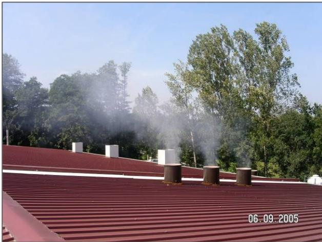
Abbildung 17: Abluftkamine über Dach
