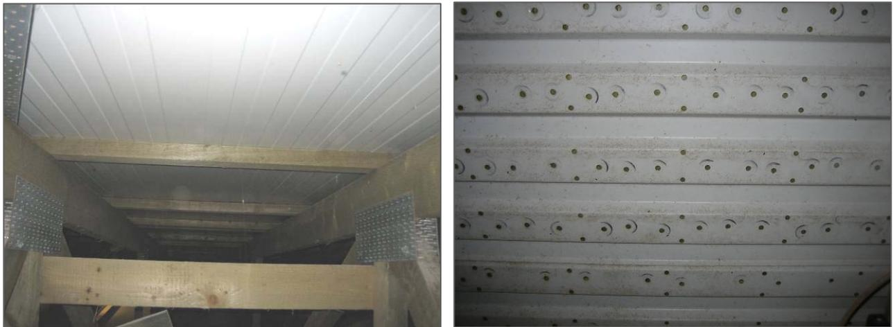
Abbildung 15: Gedämmter Dachraum als Zuluftelement (li.) und Aluminium-Trapezdecke als Tragschicht der Porendecke (re.)
