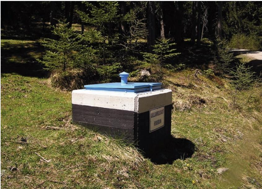
Abb. 17: Quellsammelschacht aus Beton, © AGES
