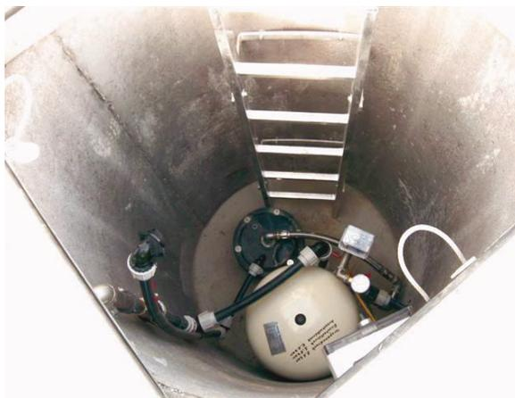
Abb. 12: Vorschacht mit Brunnenkopf und Druckerhöhungsanlage
