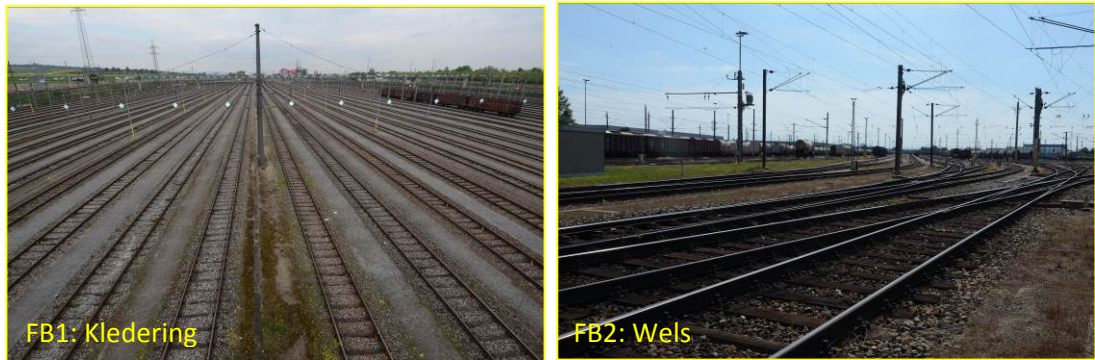
Figure 40: Switchyards (FB1 und FB2).
